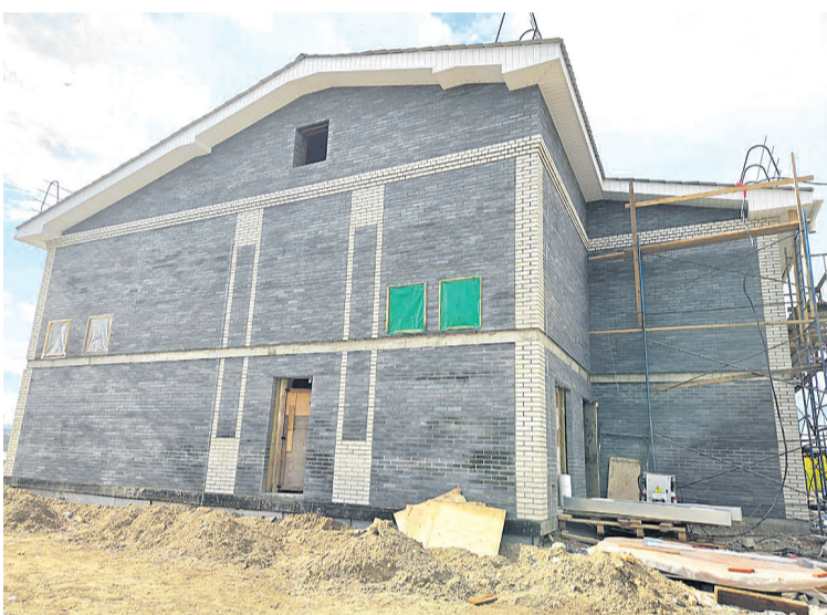
Здание насосной на Верхней Набережной почти готово.
